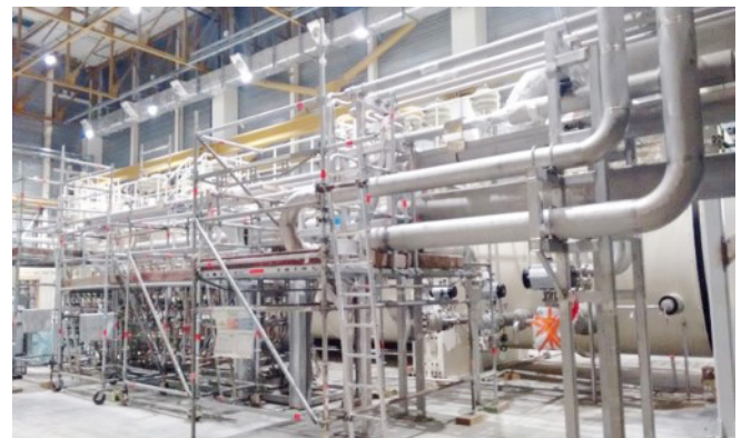
चित्र B.8 इटर साइट पर वार्म लाइन और क्रायोलाइन का संस्थापन
